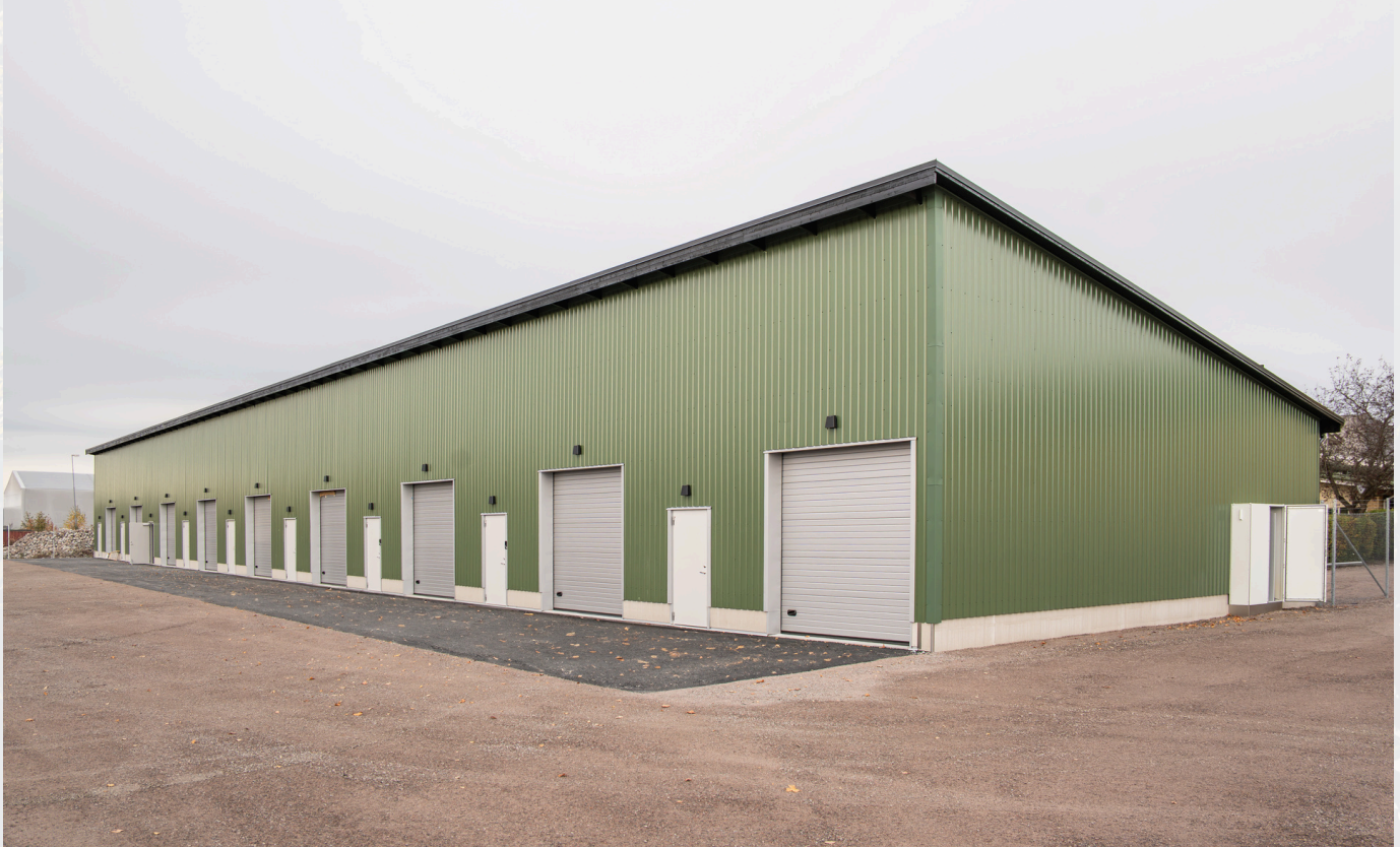
Reused building on the property Gävle Näringen 15:6
